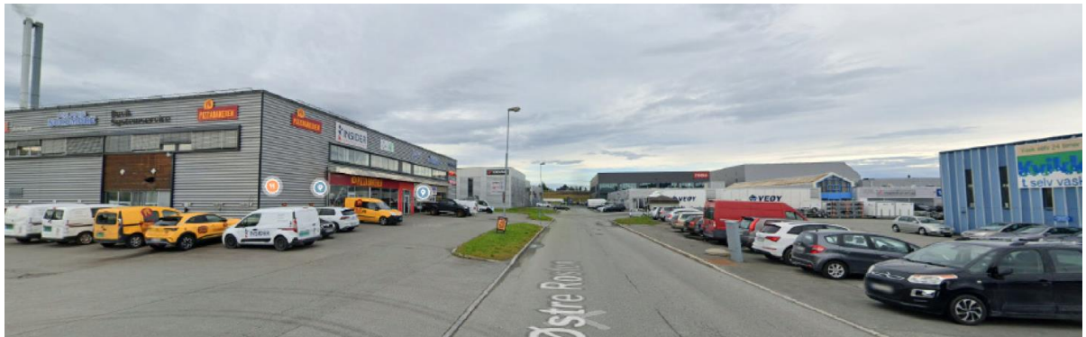
Figur 6: Ved avkjørselen fra Østre Rosten. Et næringsområde med høye etasjer, med overflateparkering mellom bygningsmassen.
