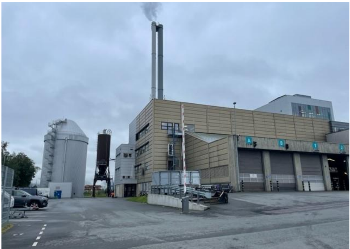
Figur 5: Østre Rosten 82, Statkrafts forbrenningsanlegg
